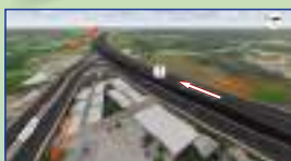
บริเวณจุดตัดถนนรามโกมุท
